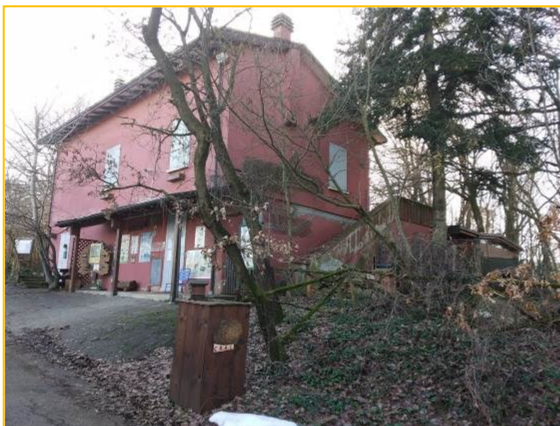
Vista nord-est del fabbricato principale (fonte: sopralluogo)
