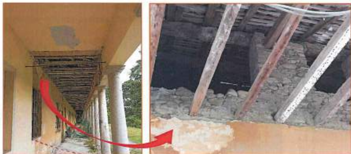
Dettaglio dei solai (fonte: sopralluogo)
