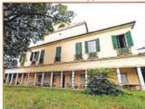
Casinetto - Prospetto est (foto del sopralluogo)
