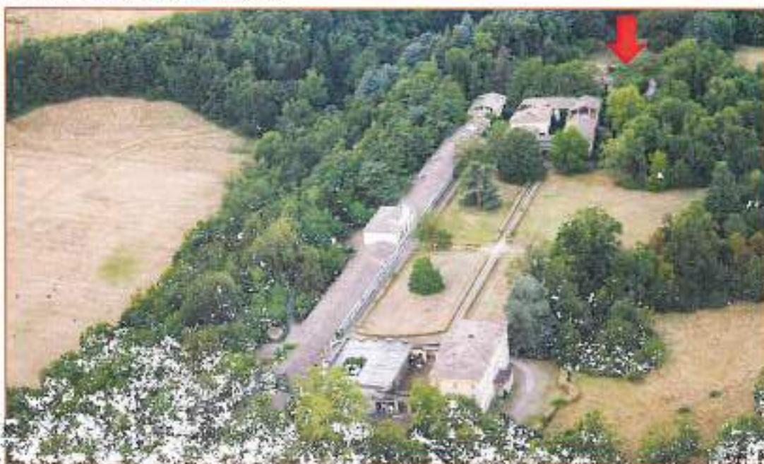
Ripresa aerea con indicazione della Casa di pietra (fonte www.manifatturaurbana.org )
