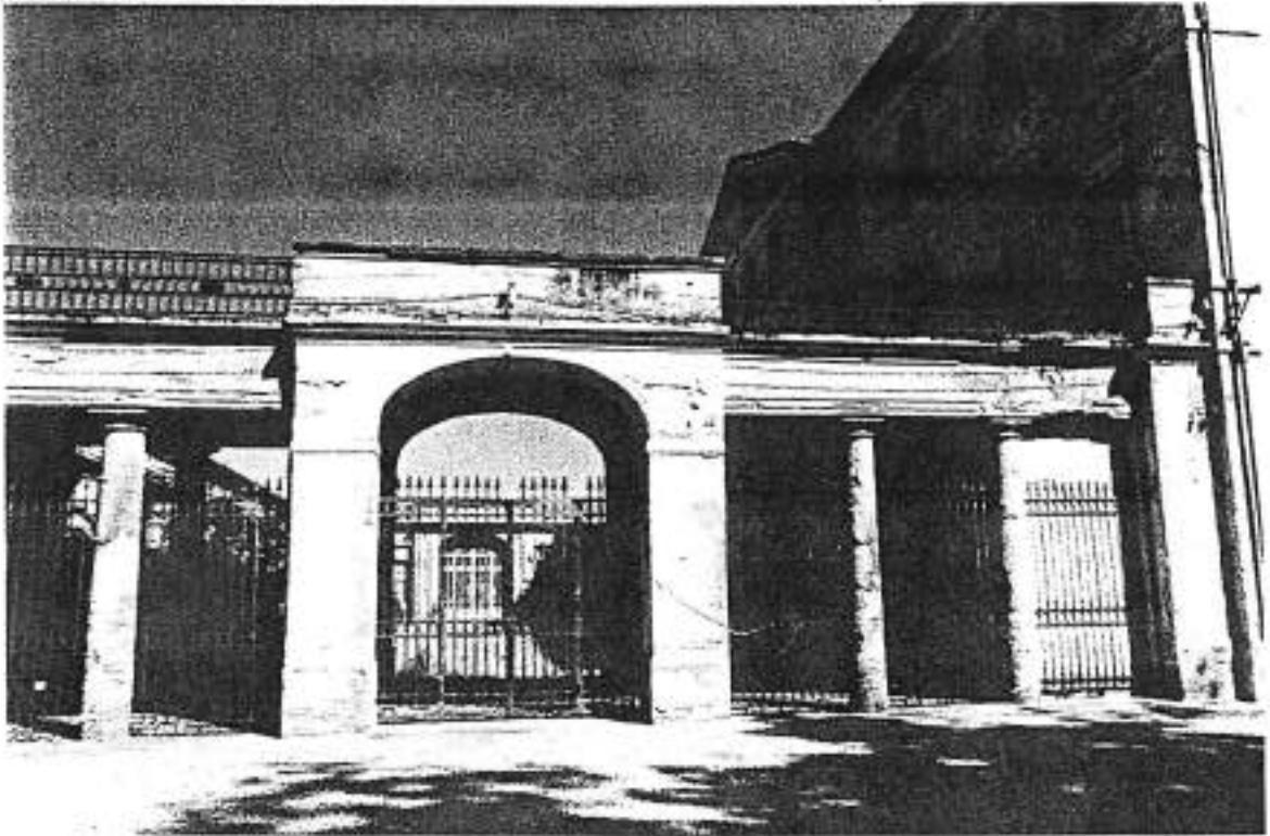
La Villa. Accesso dal Viale dei Pialani (lato Sud)
