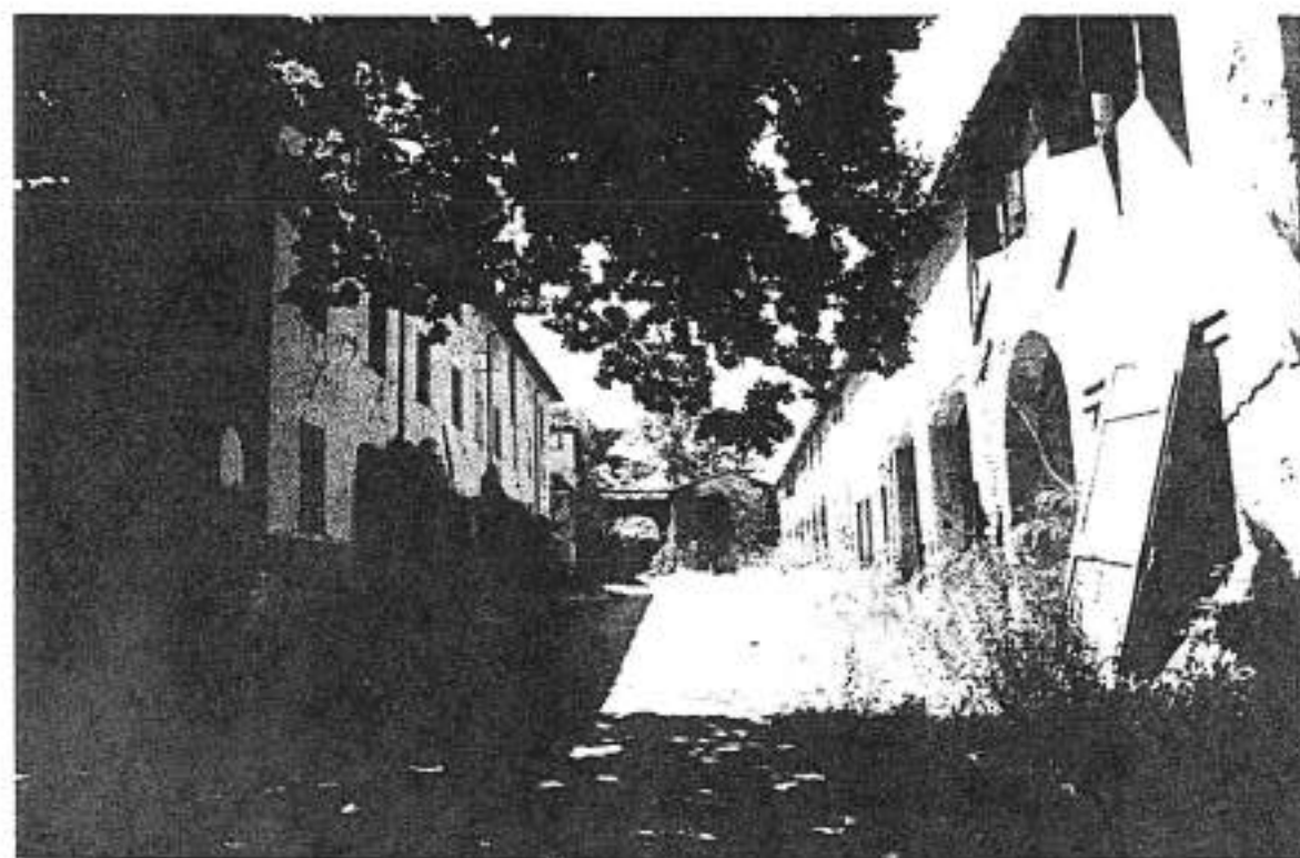
La Prolunga Punti di connessione con la Villa (Sud) e con la Corte rustica (Nord)
