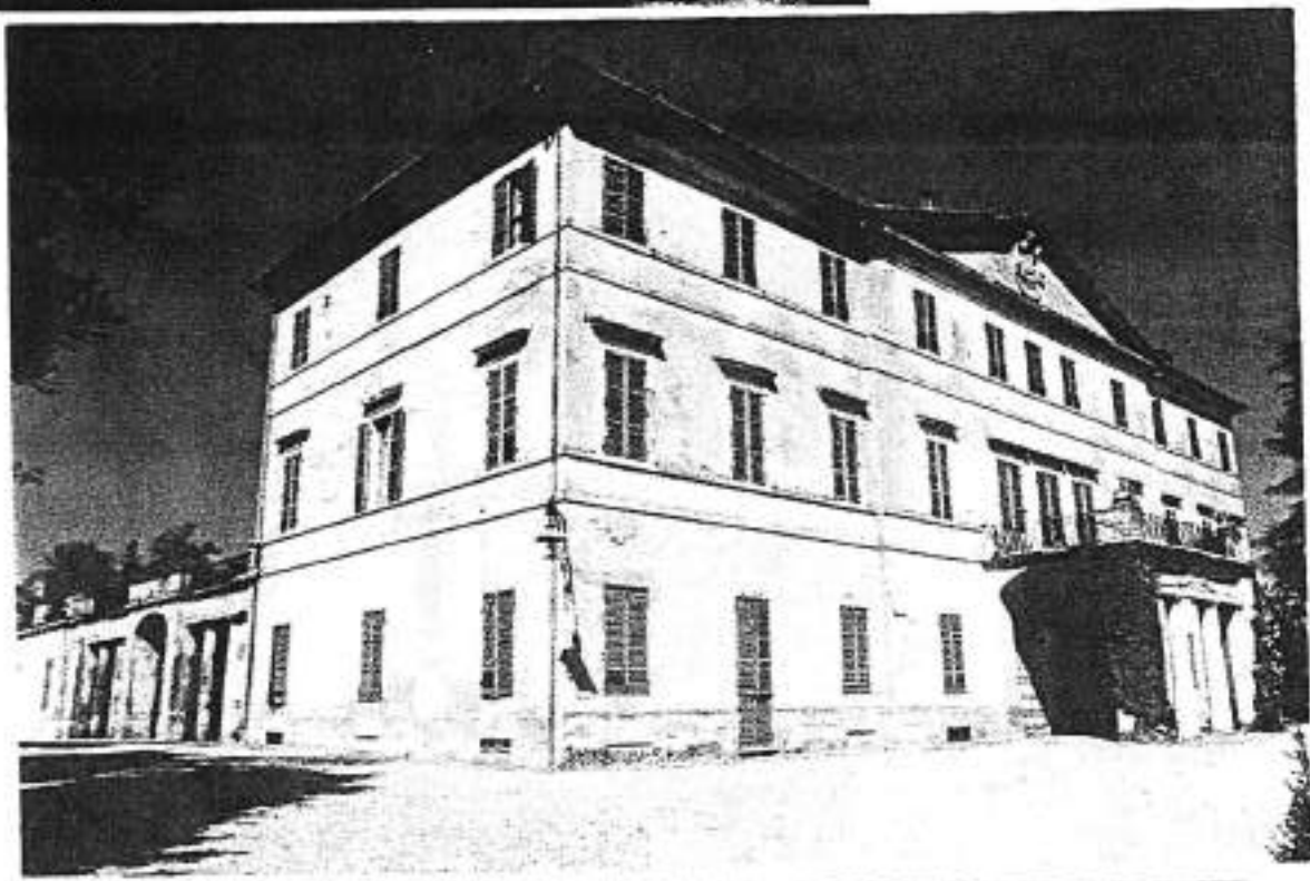
La Villa. Facciata principale (lato Est)
